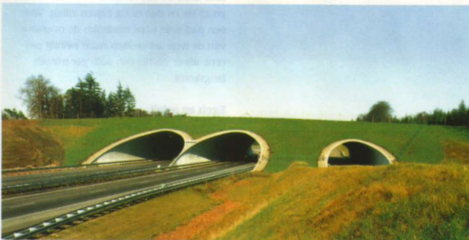
Over de A50 zijn wildviaducten aangebracht. Veel herten en ook wilde zwijnen maken er gebruik van. De foto toont het wildviaduct nabij de Woeste Hoeve. Tekening en foto Rijkswaterstaat.
