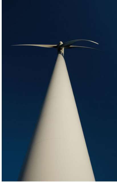
V90 3 MW windturbine. Deze windturbine van Vestas is klein vergeleken met de huidige prototypes voor offshore gebruik.
